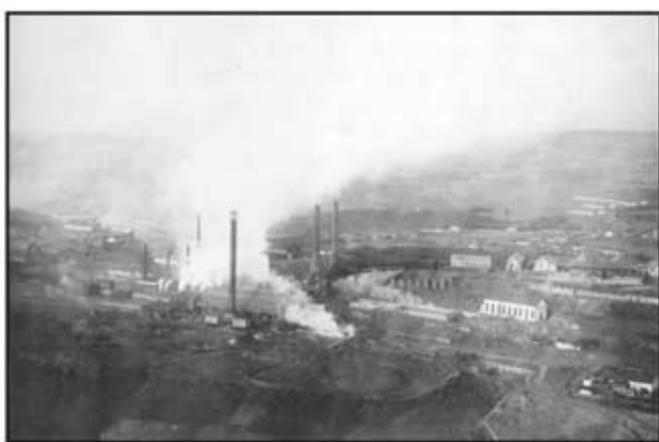
Оно што се између два светска рата подразумевало под Борским рудником чинио је цео комбинат од два рудника бакра, постројења примарне прераде и флотације, агломерације, пет високих пећи, конвертора Бесемеровог система, електролизе бакра, термоцентрале и каменолома у Кривељу.
